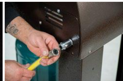
4. Avvitare il tubo flessibile al forno e aiutarsi con una chiave apposita per il perfetto serraggio.
