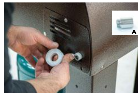
1. Isolare con teflon l'attacco gas forno e evitare il connettore (A) di collegamento.
